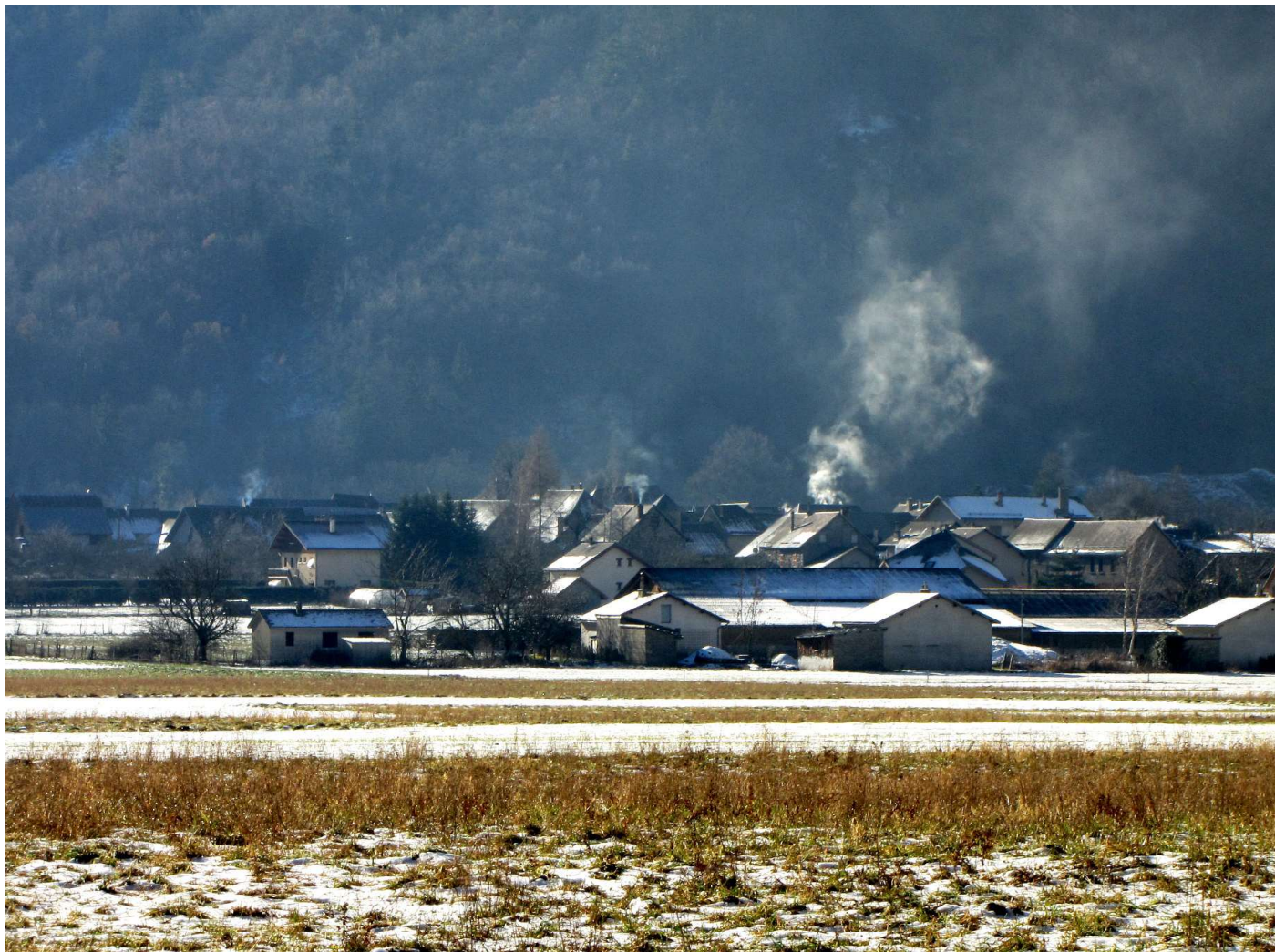
Photo 10. Chauffage au bois, village d'Entraigues
